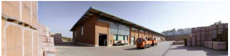
Unteres Werk II der Ziegelei in Dachau – ausgezeichnet mit dem renommierten Fassadenpreis
